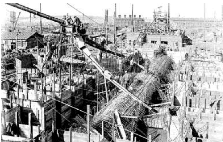
Строительство Новокузнецкого металлургического комбината.
