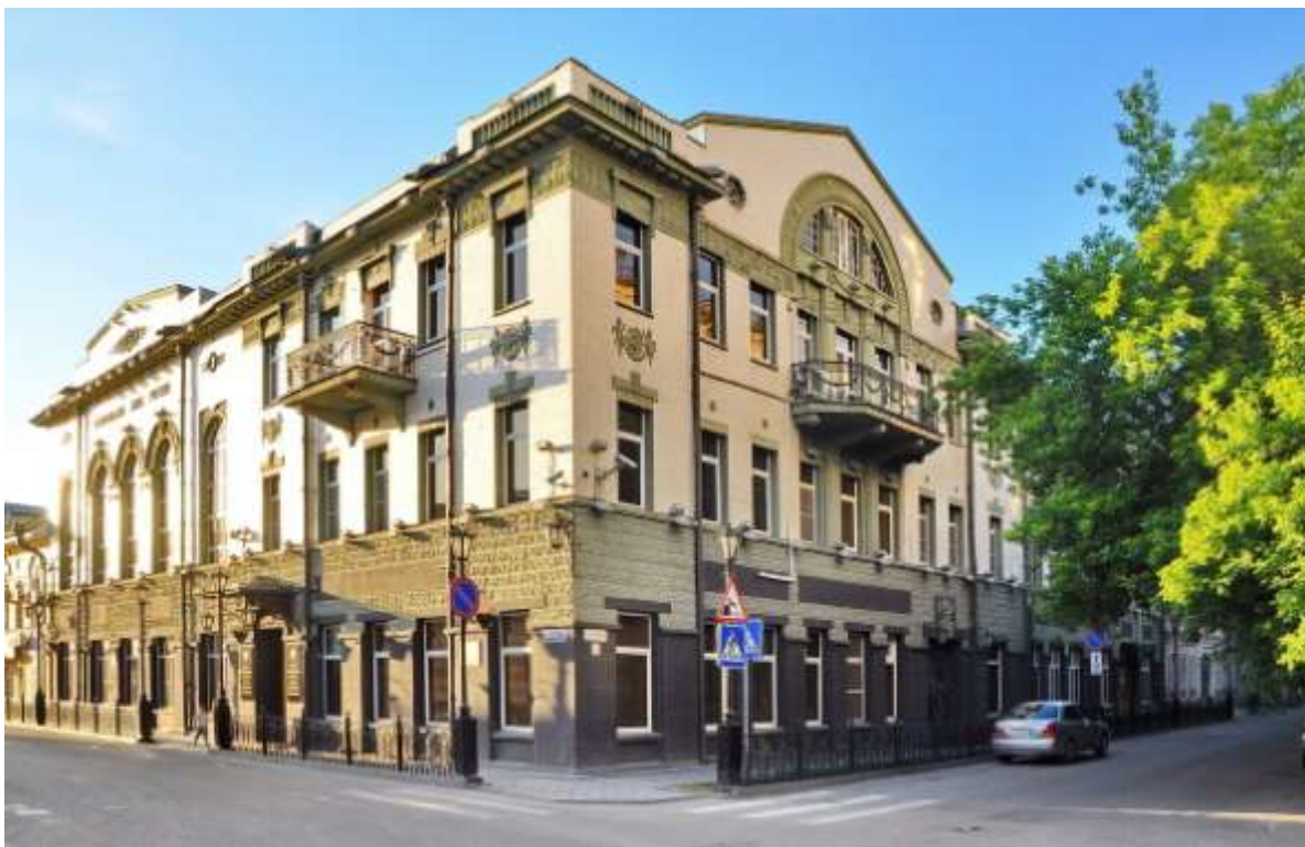
Здание Азовско-Донского коммерческого банка в Астрахани. Дата постройки: 1909 - 1910 годы. В настоящее время в здании размещается Управление Центрального банка РФ по Астраханской области.
